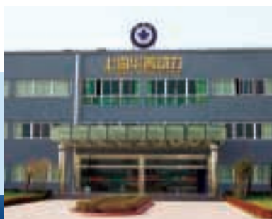
上海發動機廠房
